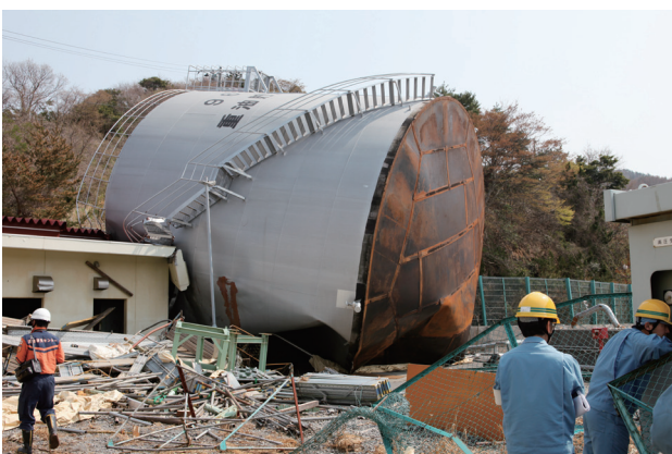
津波タンク被害
